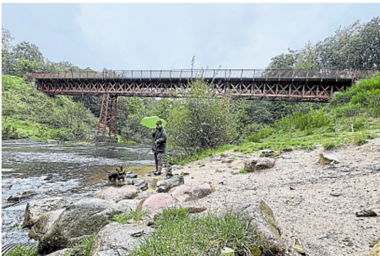
Die wiedergefundene Brücke wurde 1899 erbaut, war 85 Jahre lang in einem Damm verborgen und ist 2014 restauriert worden.
